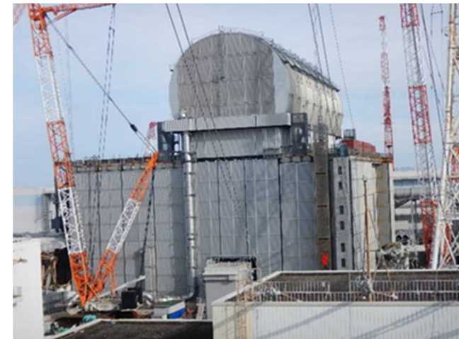
3号機原子炉建屋外観写真の例
