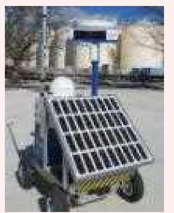
線量率モニタの設置状況
