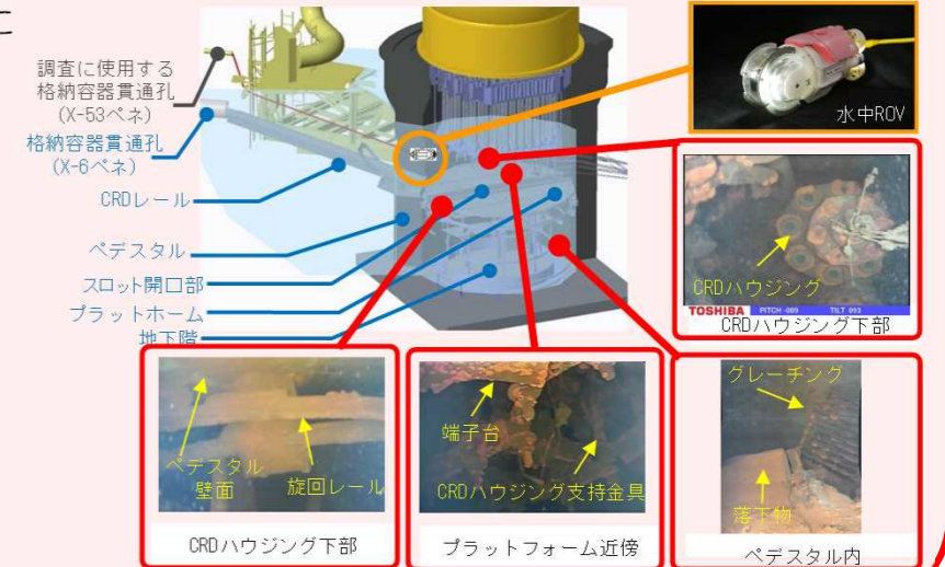
ペDESTAL内部の状況
