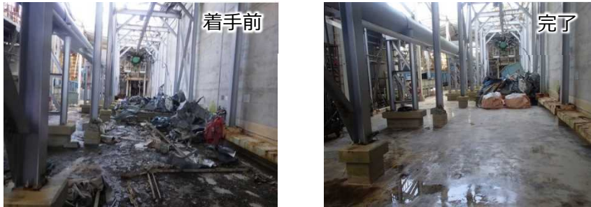
A工区 (2号機Rw/B側) 準備作業状況
