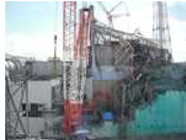
大型ガレキ撤去・着手前（2012年2月）
