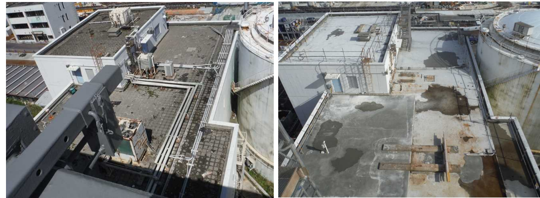
3,4号機増設S/Bガレキ撤去前
