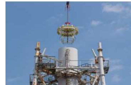
頂部蓋設置作業状況 (5月1日)
