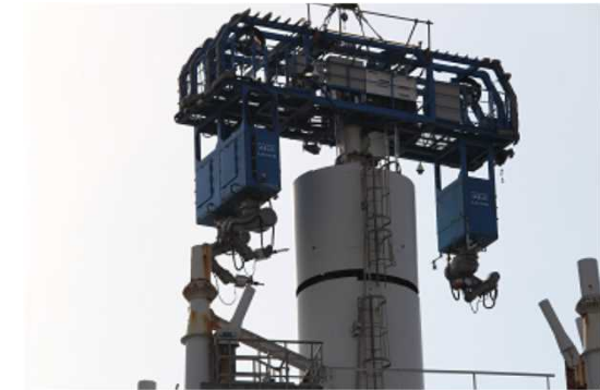
23ブロック目 解体作業状況(4月29日)
