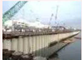
海側遮水壁 鋼管矢板打設完了状況
