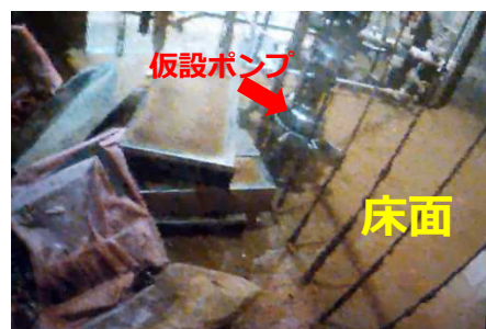
2号機Rw/B地下1階(最下階)の 床面露出状況
