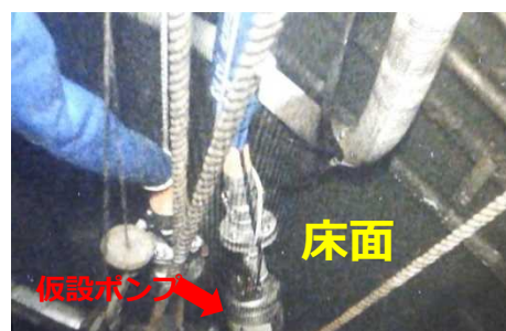
2号機T/B地下1階(最下階)の 床面露出状況
