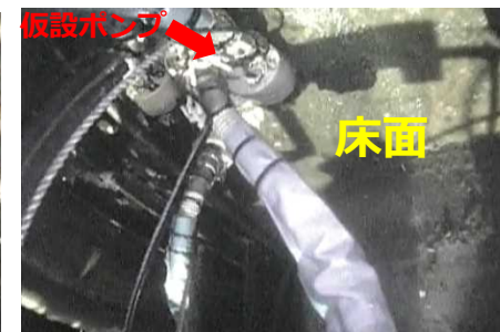
3号機T/B地下1階(最下階)の 床面露出状況
