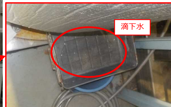
現場状況（写真）
