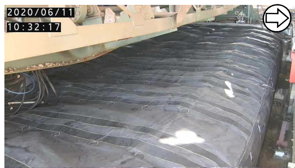
エアモルタル充填（撮影日：2020.6.11）
