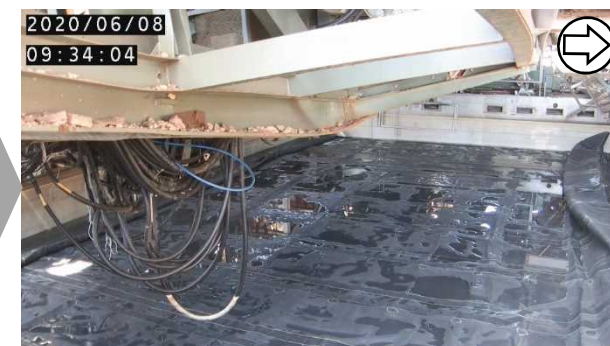
養生バグ展張（撮影日：2020.6.8）
