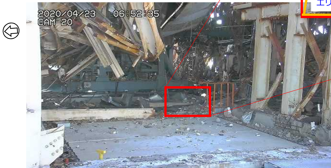
支障ガレキ撤去範囲（撮影日：2020.4.23）
