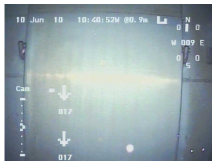
プールゲート正面の様子
