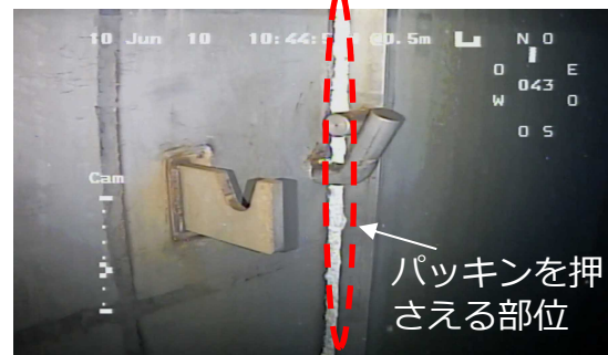
プールゲート支持軸の様子
