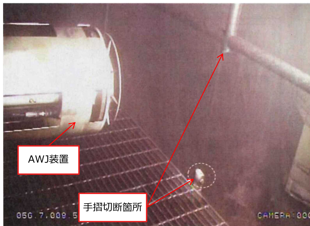
手摺（縦部）の切断状況
