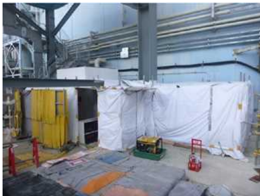
既設装備交換所
