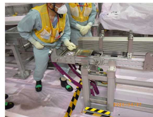
曲げ戻し燃料棒の挿入
