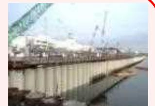
海側遮水壁 鋼管矢板打設完了状況
