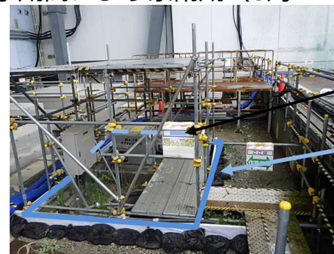
暫定対策後（7/14） （サブドレンNo.18ピット周辺）
