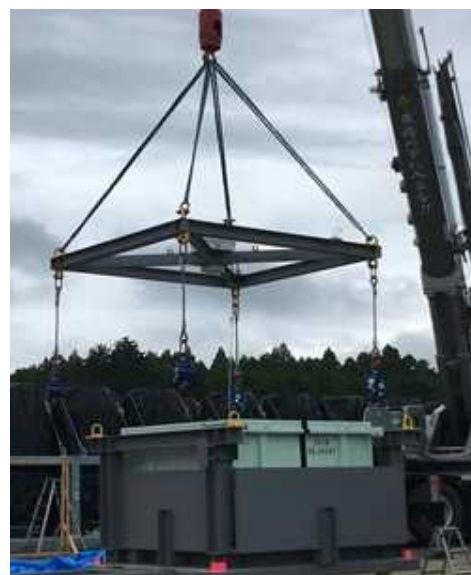
玉掛け・吊り上げ訓練
