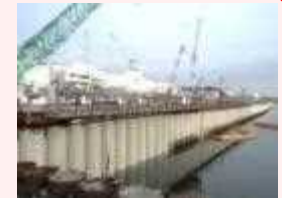
海側遮水壁 鋼管矢板打設完了状況
