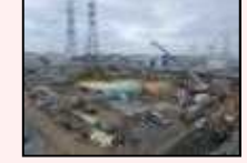
H1東エリア解体後の様子
