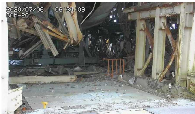
ガレキ撤去前(撮影日:2020.7.6)
