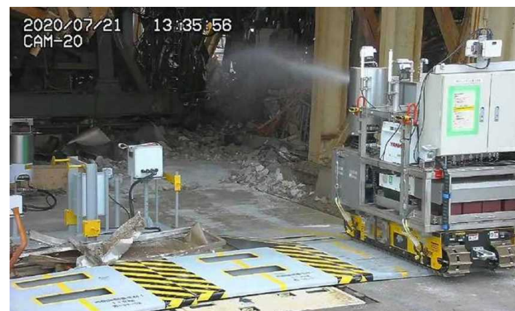
飛散防止剤散布(撮影日:2020.7.21)
