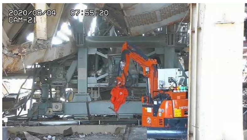
ガレキ撤去作業(撮影日:2020.8.4)
