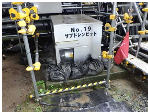
暫定対策後（7/14） （サブドレンNo.19ピット）
