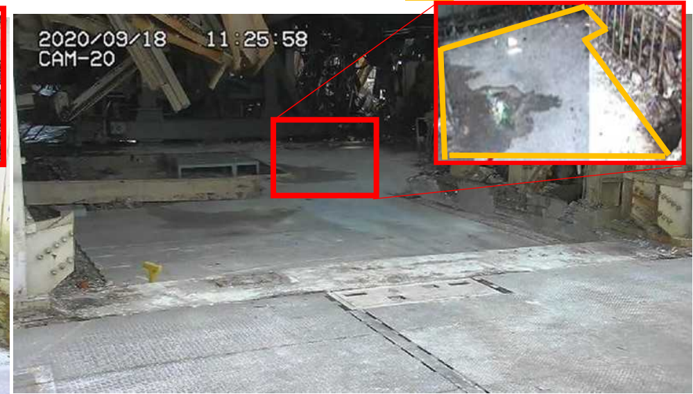
ガレキ撤去後(撮影日:2020.9.18)
