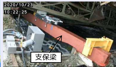
＜燃料取扱機 支保設置状況＞
