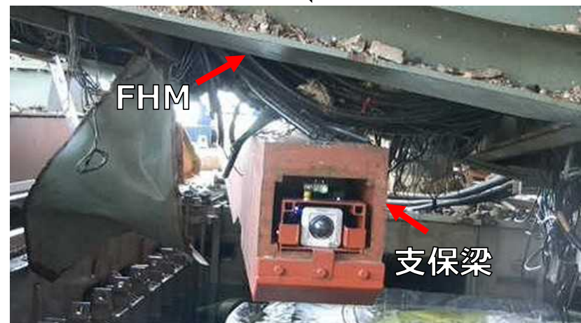
II-a. 支保梁挿入中 (撮影日: 2020.10.20)
