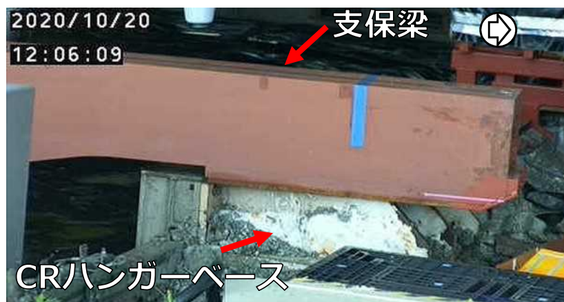
II-b. 支保梁挿入完了 (撮影日: 2020.10.20)
