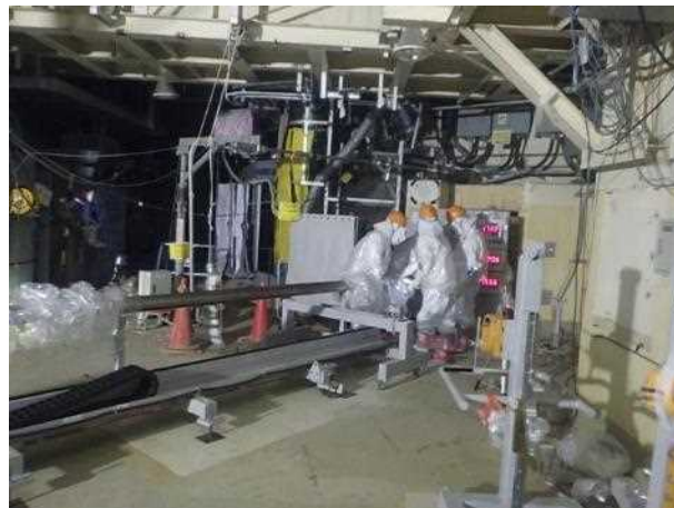
X-6ペネ前での調査装置設置作業
