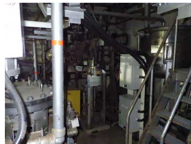
廃棄物処理建屋内の写真②
