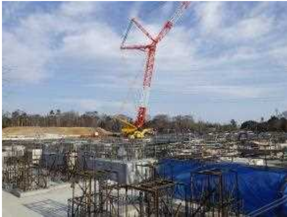
① 建屋 基礎工事状況(2018/3/14)
