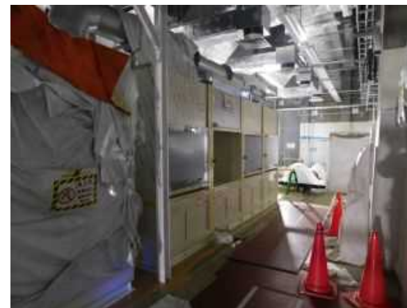
フード室 整備状況 2020.9.30
