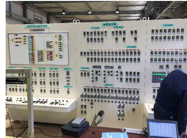
監視設備室 建屋監視盤 外観状況 2020.7.30
