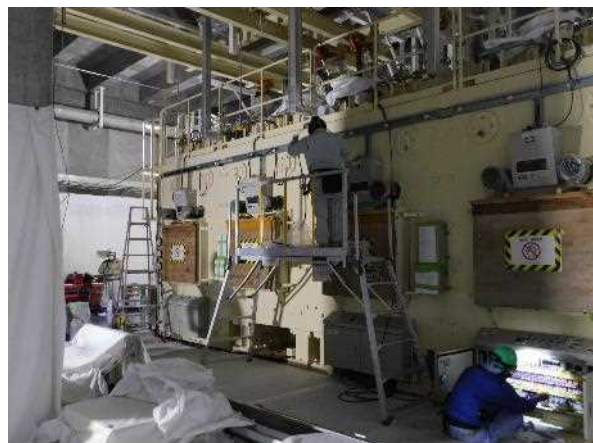
鉄セル室 付属品、盤類取付作業 2020.8.28
