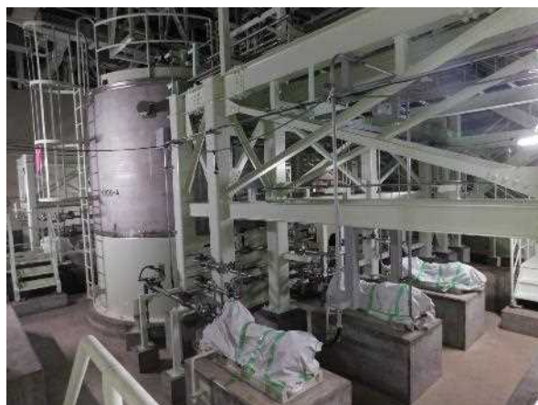
液体廃棄物一時貯留設備 液体廃棄物一時貯留室状況 2020.8.28
