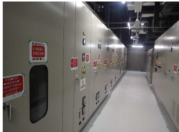
電気室 受電完了後の状況 2020.9.30
