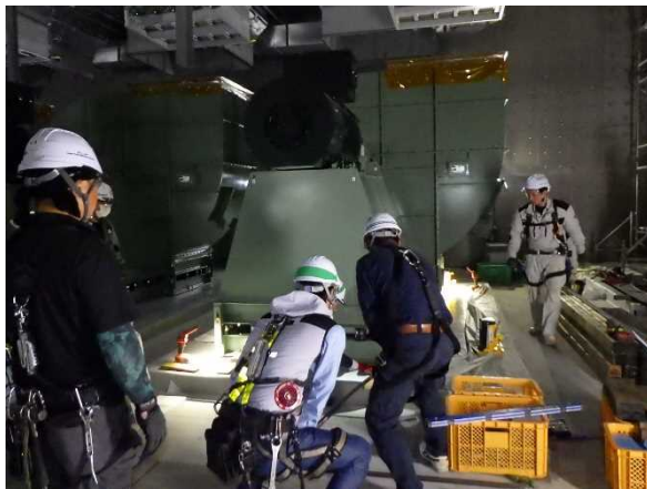
衛生空調機械室 送風機据付作業 2020.7.6
