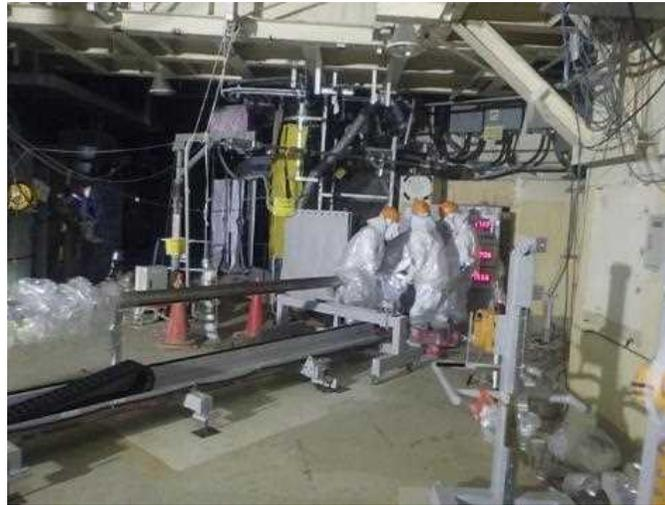
X-6ペネ前での調査装置設置作業
