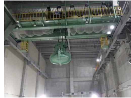
廃棄物クレーン設置完了
