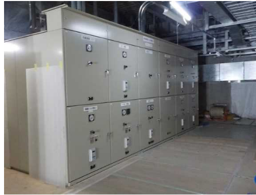
電気品等設置完了
