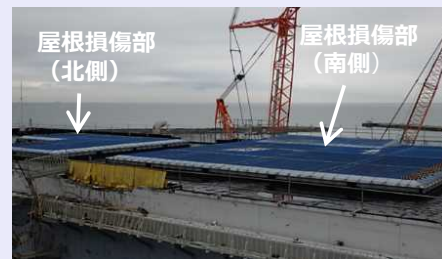
＜3号機タービン建屋（T/B）・雨水対策の実施＞ 2020年8月 雨水カバー設置完了
