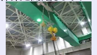
＜天井クレーン主巻での収納缶吊り具の取り扱い＞
