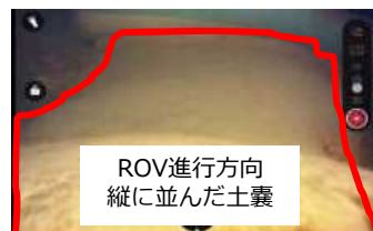
PMBの土嚢状態(現在)
