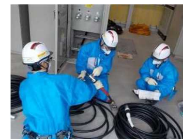
ケーブル導通訓練
