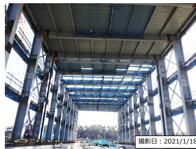
屋根工事の状況（内部より）
