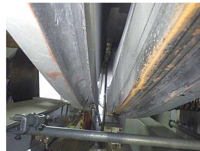
キルンシール部分解調査状況
