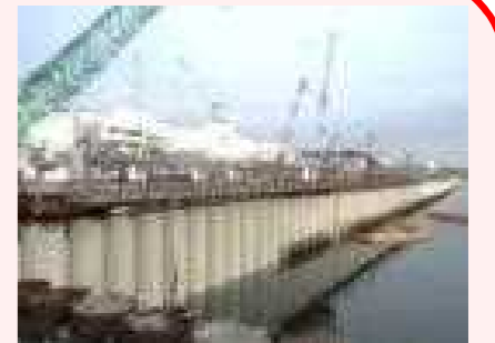
海側遮水壁 鋼管矢板打設完了状況
