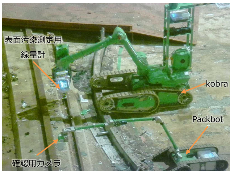
オペフロ内調査状況
