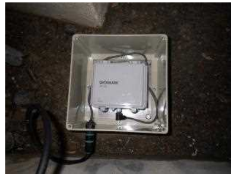
3号機に設置した地震計 (1階レベル)
