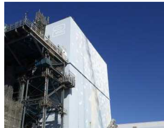
2号機原子炉建屋 点検写真例（南側）
