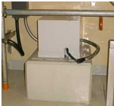
6号機の既設地震計
