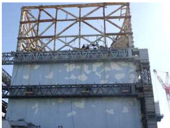
1号機原子炉建屋 点検写真例（北側）
