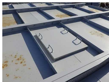
天板点検口（蓋あり）
