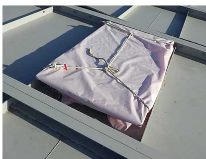
天板点検口（蓋なし、養生実施）
