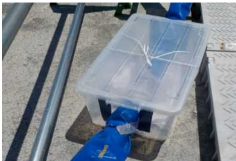
【耐圧ホース接続箇所】
