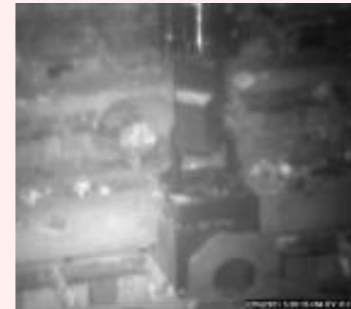
燃料取り出し (556体目) の状況 (撮影日2021年2月26日)
