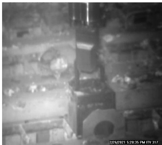
3号機での燃料の吊り上げ（566体目）
