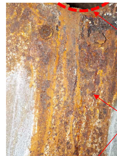
ダクト内部側面（配管側）写真
