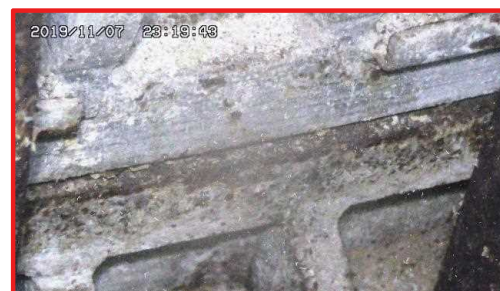
PCVフランジ部
