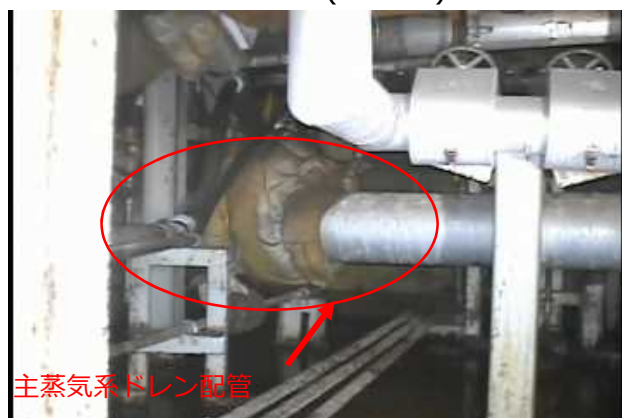
主蒸気系ドレン配管
