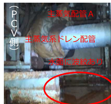
主蒸気配管 A (伸縮継手下側)
