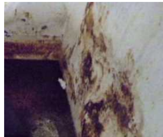
図16. 容器内面・補修箇所の状況
