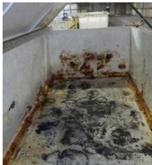
図15. 容器内面・底面の状況 (水回収後)
