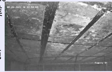
＜シールドプラグ下部の状況＞
