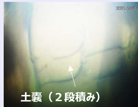
＜確認されたゼオライト土嚢の状況＞
