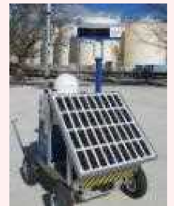
線量率モニタの設置状況
