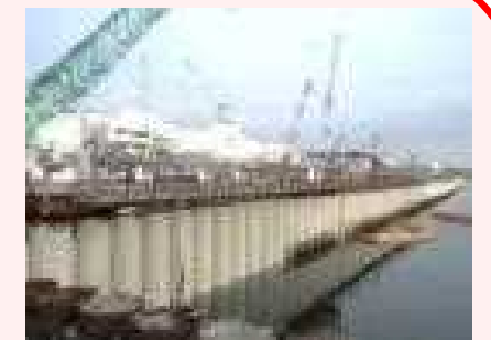
海側遮水壁 鋼管矢板打設完了状況
