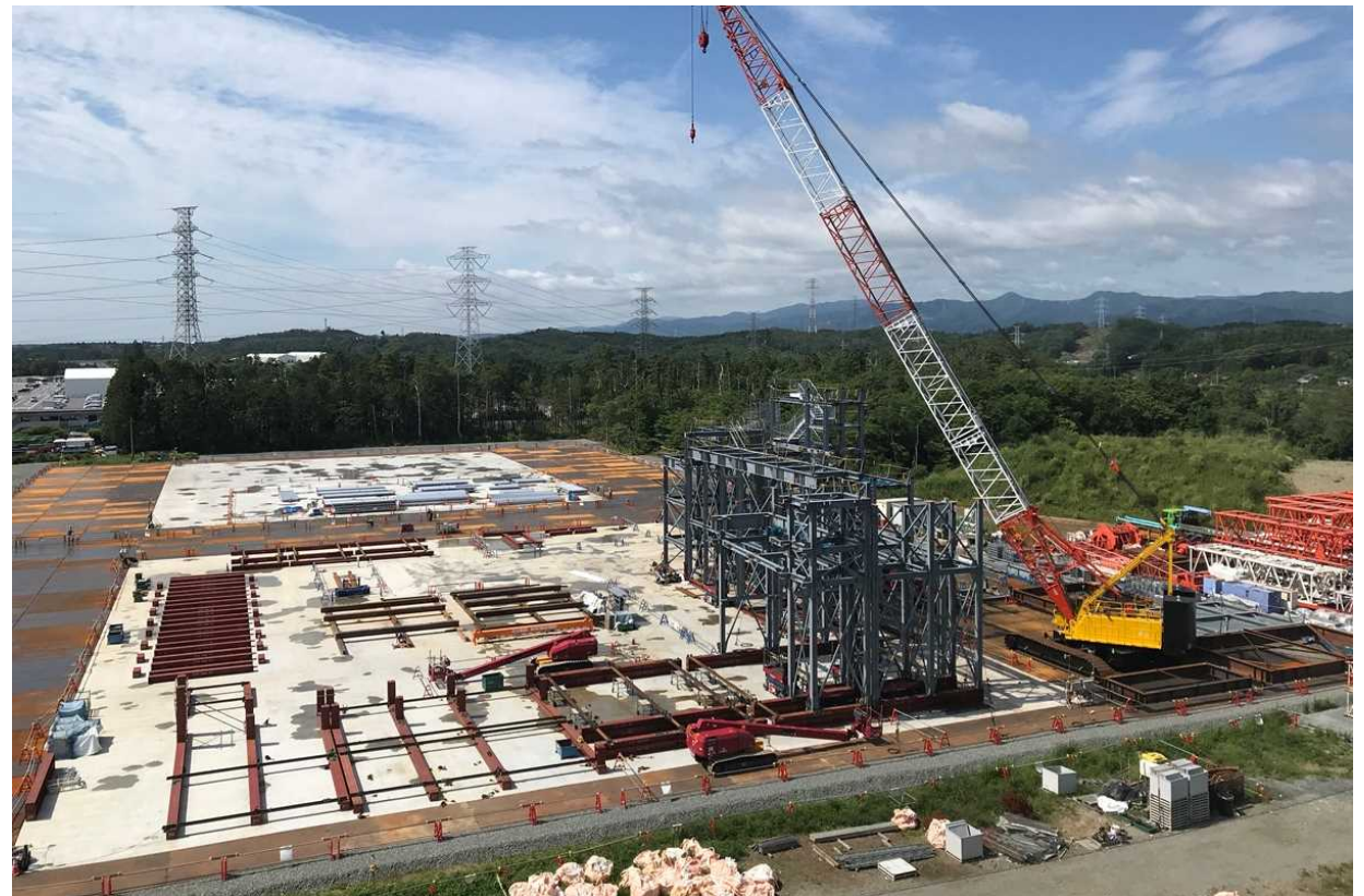
構外ヤード全景（2021年6月21日時点）
