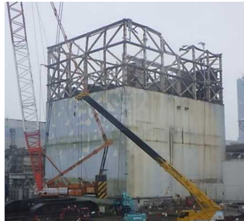
1号機原子炉建屋全景（2021年6月19日時点）
