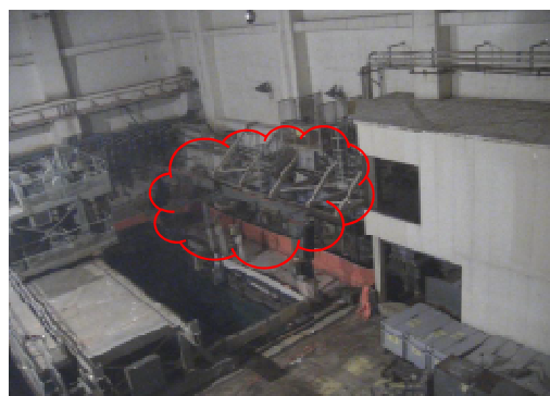
⑤干渉物撤去 (SFP南側既設設備撤去) ※4
