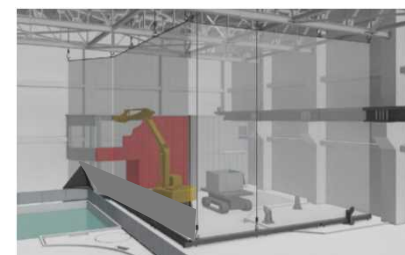
④干渉物撤去 (FHM操作室撤去) ※3
