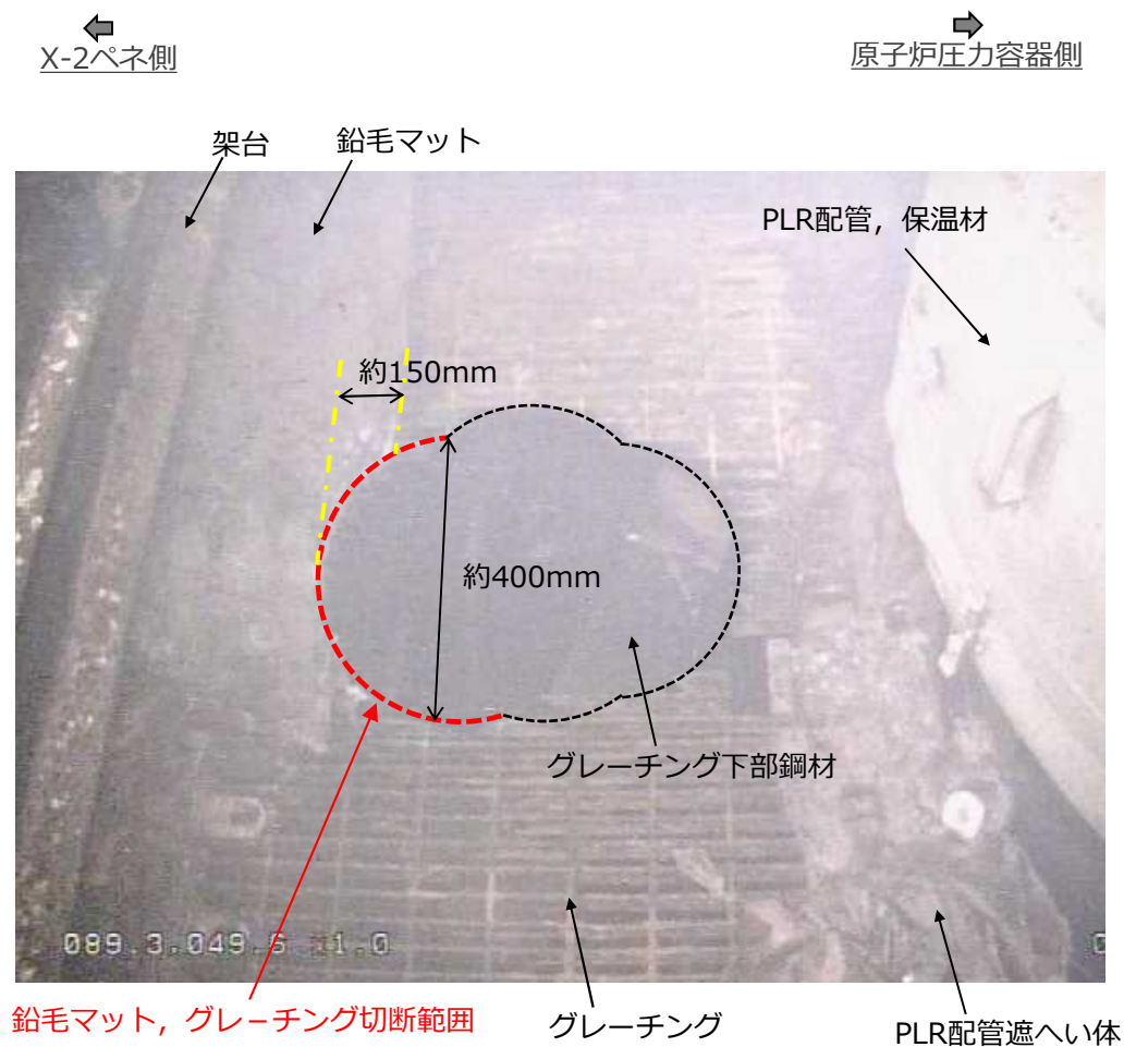
鉛毛マット/グレーチング切断写真
