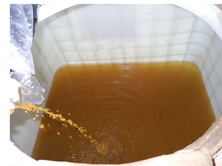
漏えいした水の受けタンク
