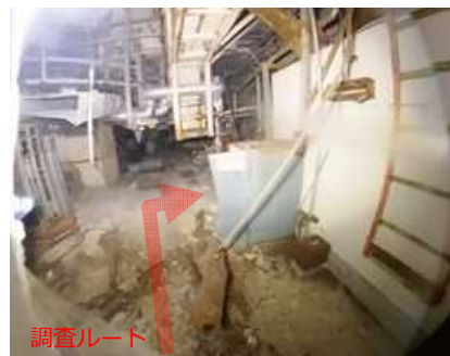
写真3B: プール壁の南西部
