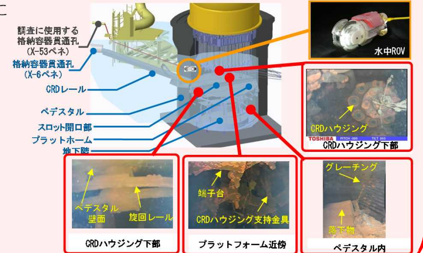
ペDESTAL内部の状況
