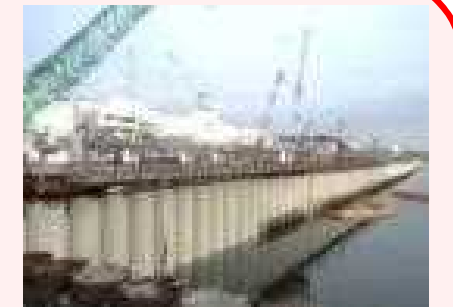
海側遮水壁 鋼管矢板打設完了状況
