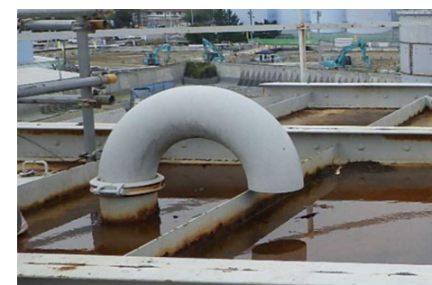
タンクの通気管 (高性能フィルタ設置後)
