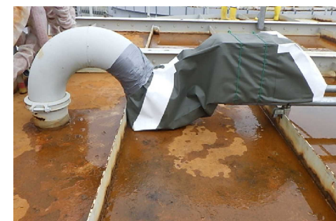
タンクの通気管 (高性能フィルタ設置後)
