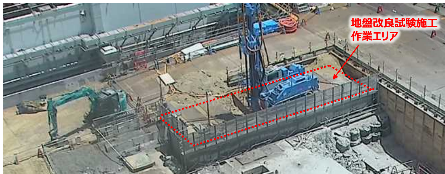
地盤改良重機配置状況
