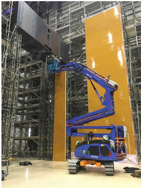
模擬天井クレーン下部除染
